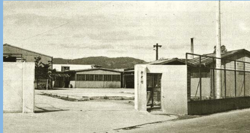
九州変圧器株式会社設立
