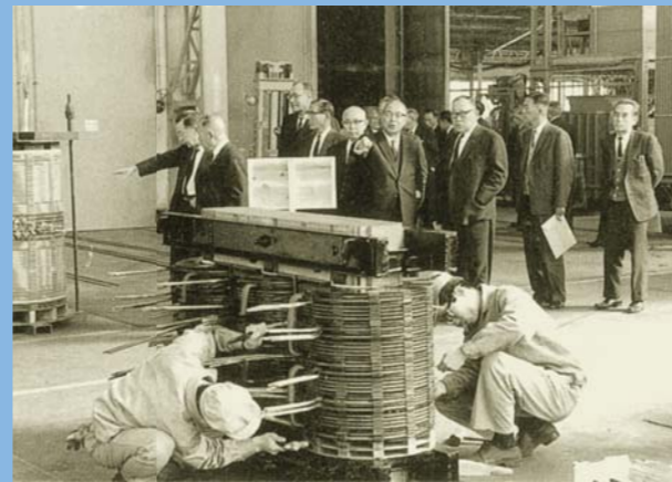
大形変圧器工場
