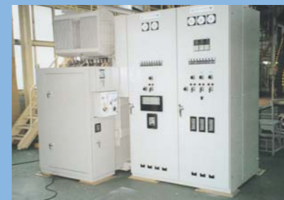
22kVスポットネットワーク受電設備
