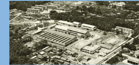
キュービクル工場新設・温水器工場増築竣工
