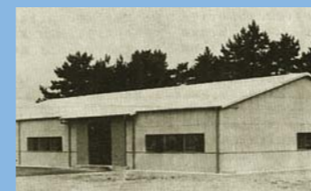
温水器工場完工
